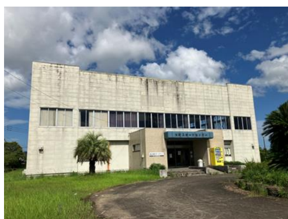
写真 大町町スポーツセンター外観
