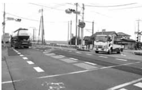
●「右左折誘導のカラー表示」がされている大町小学校前交差点
