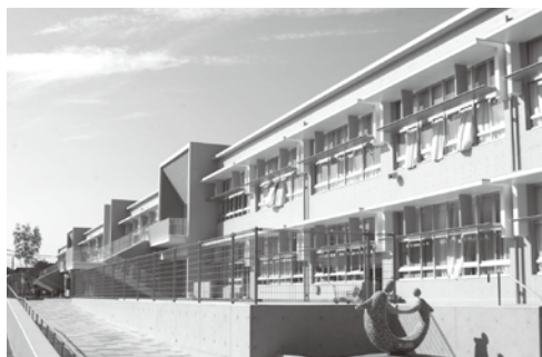
●平成25年に完成した 「小中一貫校大町ひじり学園」校舎
