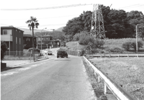
●右左折レーンの拡別が計画されている町道浦川内線
