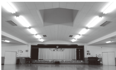
▲大町保育園プレイルーム空調設備改修事業
