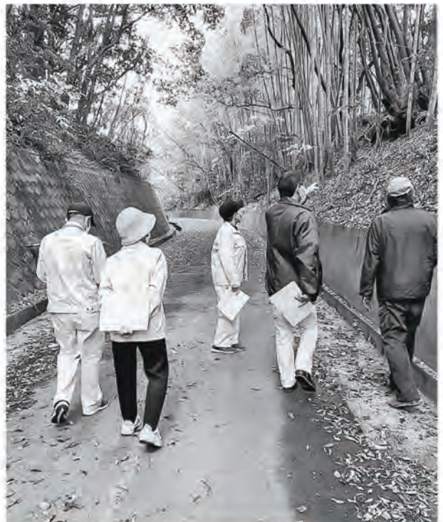
▲土木調査の様子
