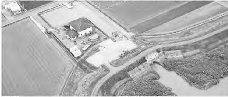
▲上空から見た下瀧排水機場
