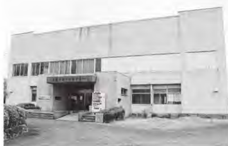
▲大町町スポーツセンター
