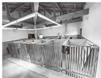
▲災害救助犬が常駐できるように10頭分の犬舎が設けられています
