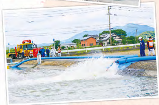
▲移動式排水ポンプ操作訓練の様子
