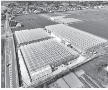
▲大町に建設されたキュウリの施設園芸団地
