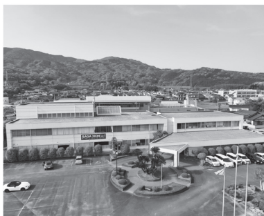
▲建築から34年が経過している大町町役場
