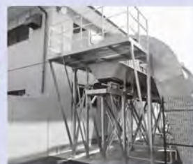
▲完成(除塵機嵩上げ)
