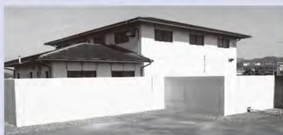
▲完成(止水壁設置)
