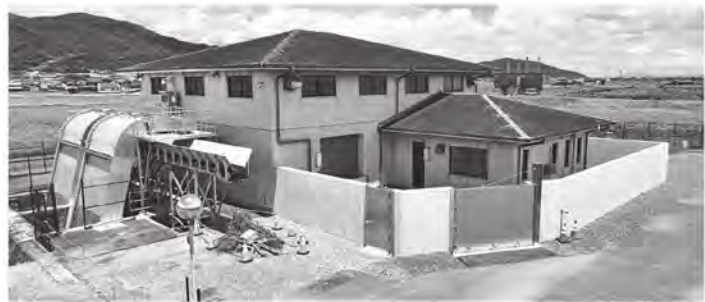
▲排水機能強化が進められる下潟排水機場
