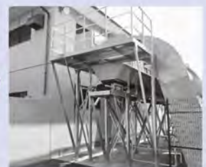
▲完成(除塵機嵩上げ)
