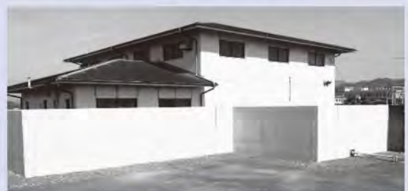
▲完成(止水壁設置)
