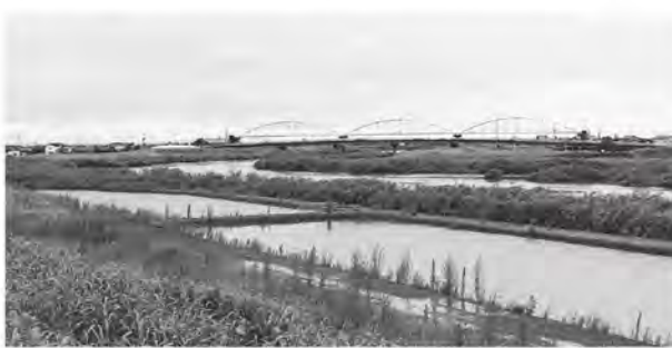
▲六角川に設置された湛水池(写真手前)
