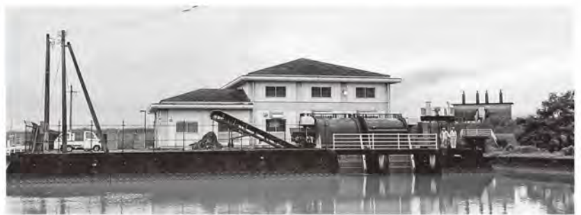
▲整備工事が進められる下大町排水機場
